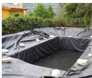
Construcció Biopool amb làmina EPDM.
